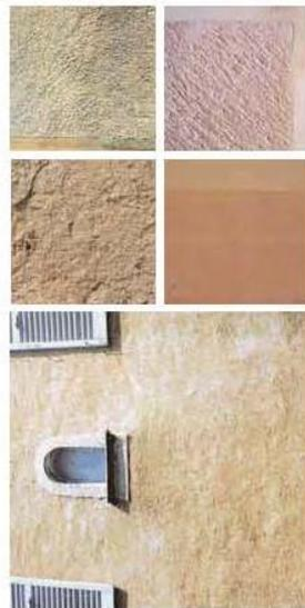
Les enduits couvrants masquent les pierres des murs et sont associés à des modulations\* qui soulignent la composition de la façade et jouent un rôle technique.
