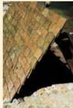
▲ Avant zinc au four, zinc recouvert de matériaux enduits au lait de chaux.
