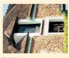
▲ Lucarne pignon à une façade maçonnée qui vient au-devant du toit. La lucarne engagée (ou passante) a une ouverture "noyée" sur la façade.
