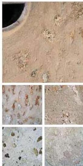
Les enduits à pierre vue\* affleurent le nu extérieur des pierres. Ainsi, les tons jaunes, orangés ou gris des pierres s'associent à un tons blond de l'enduit constitué de chaux et de sable de Fontainebleau.
