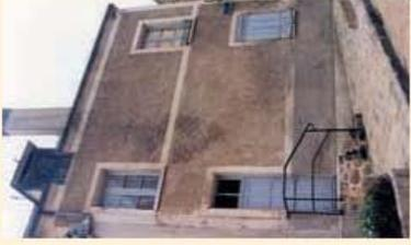
sur le nu du mur. Elles courent de façon continue horizontalement et verticalement sur la façade. Elles sont constituées de chaux ou de plâtre et chaux.
