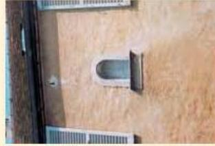
▲ L'enduit couvrant doit être couronné en haut et en bas par la pierre.
